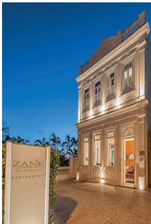
Fachada del Zank by Toque, en el barrio de Rio Vermelho (arriba) y el deck con vista de la ciudad (a un lado)
